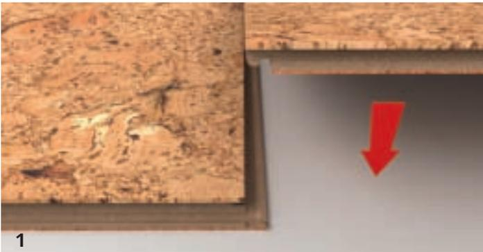
1 Der Boden wird kopfseitig dicht an der nebenliegenden Dielenschiene abgesenkt.
