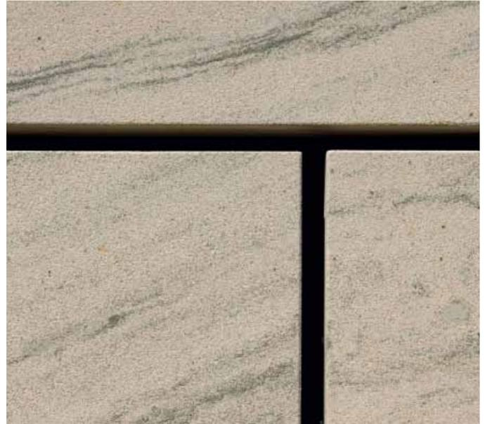
**Selbst da, wo die größtmöglichen Fassaden-Panels zum Einsatz kommen,** entstehen Fugen zwischen den einzelnen Elementen. Das muss allerdings keinen „Bruch“ in der Gestaltung bedeuten: Trennen, ordnen, strukturieren oder rhythmisieren – oft sind es gerade die Fugen, die einem Gebäude seinen besonderen Charakter verleihen. Umgang mit dem Fugenbild ist ein fester Bestandteil architektonischer Gestaltung.
