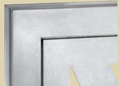
*Jede Schweißnaht wird in fünf aufwändigen Arbeitsschritten geschliffen.*
