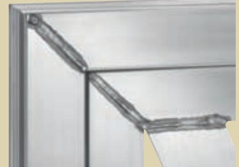
*Alle Profilstöße werden in handwerklicher Präzisionsarbeit verschweißt.*
