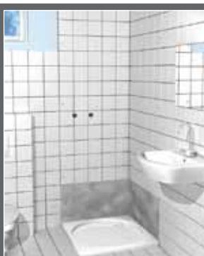
SCHRITT 4: DUSCHBOARD Installation der neuen Duschwanne oder des bodenebenen Duschboards.
