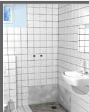
SCHRITT 3: VORBEREITUNG Ausbau der Duschwanne, Glättung von Wand und Boden.
