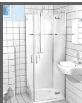
SCHRITT 6: DUSCHABTRENNUNG Installation der neuen Duschabtrennung und der Duscharmatur.
